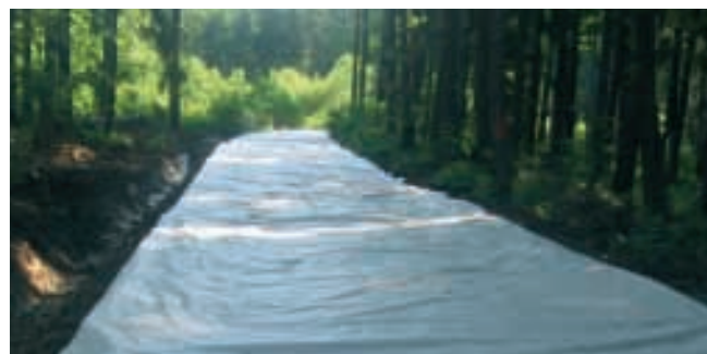
Строительство лесной дороги
